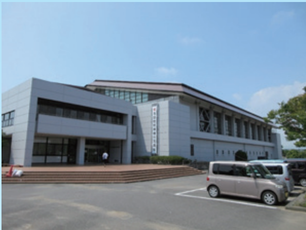
大きな空間を有する体育館の空調設備設置の例 1
