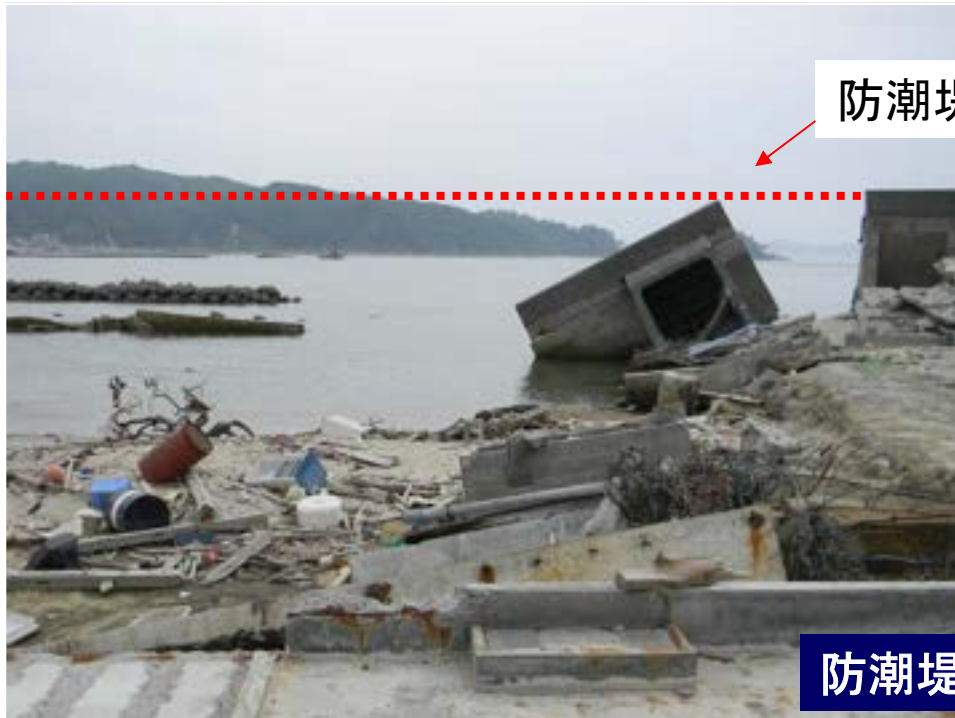
住宅の基礎のみ残存し、上部構造が流出
